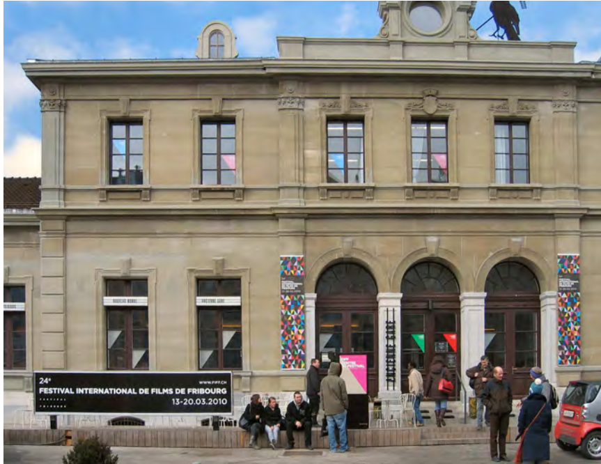
der alte Bahnhof (Ancienne Gare) dient als Festivalzentrum mit Restaurant
